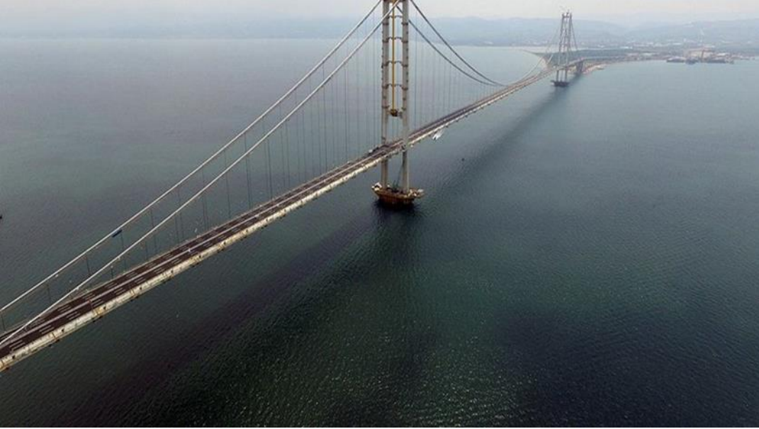
Osmangazi Köprüsünün Ayaklarının Batırılması
